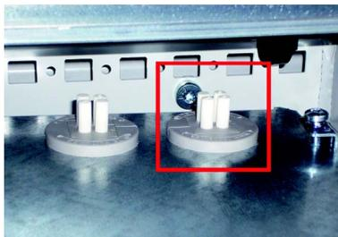
2. Introdurre la linea di comando, misurazione o comunicazione nel Multicluster Box lungo il passacavi.
